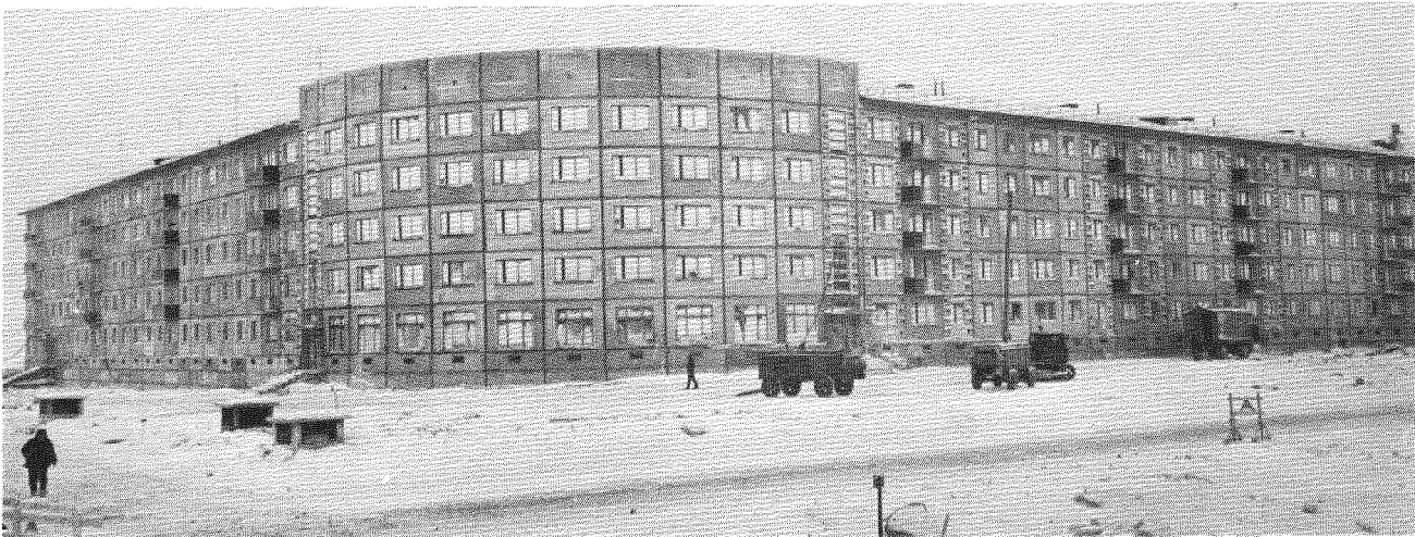
Рис. 2. Фрагмент фасада блока зданий.
