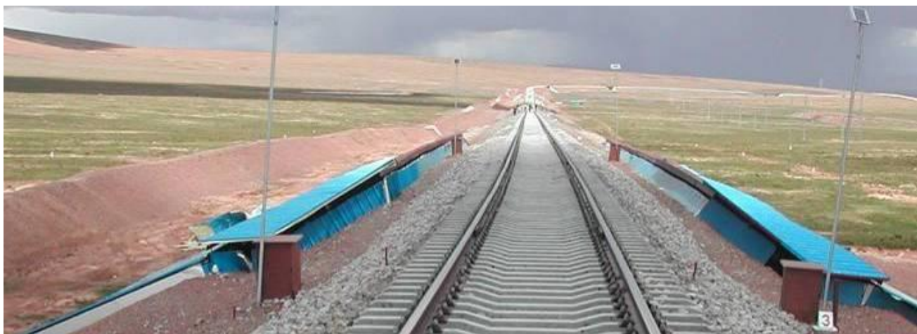
Рис. 5. Солнцесадкозащитные навесы на Цинхай-Тибетской ж.д. на участке льдистых грунтов в основании, август 2006 г
