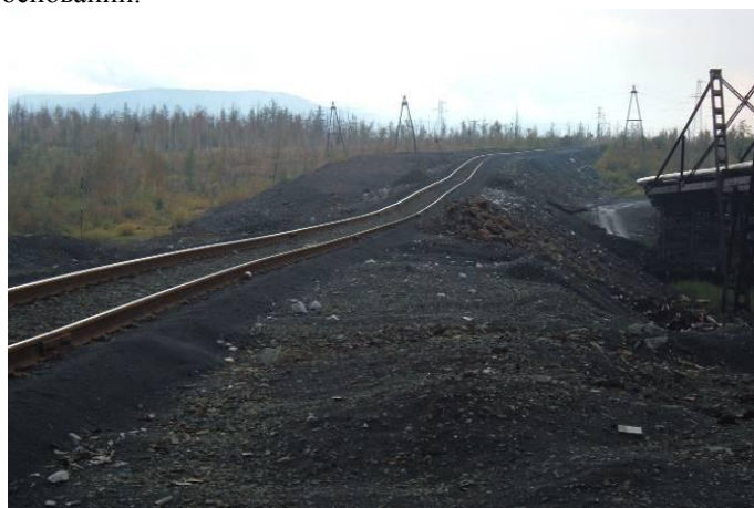
Рис. 2. Длинноволновая продольная деформация полотна железной дороги у разъезда «Валёк». Длина волны \approx 120 м
