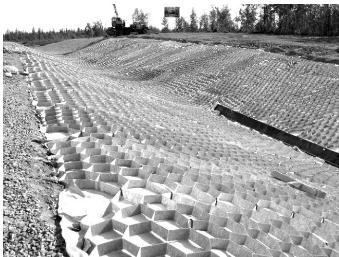
Рис. 1. Строительство противоэрозионных и противооползневых конструкций с применением георешетки в 2009 г.
