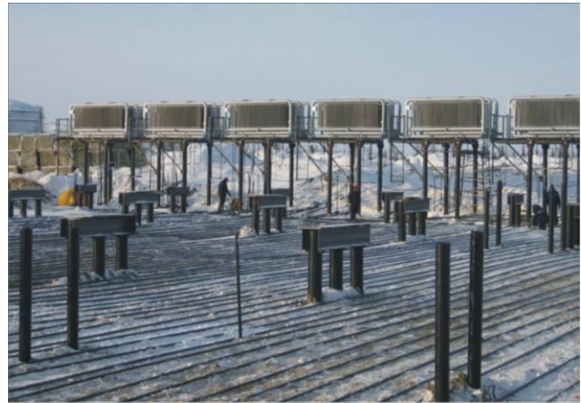
Рис. 2, 3. Монтаж парожидкостных систем термостабилизации многолетнемерзлых грунтов оснований на строящихся промышленных объектах ООО «Газпром добыча Надым» на п-ове Ямал
