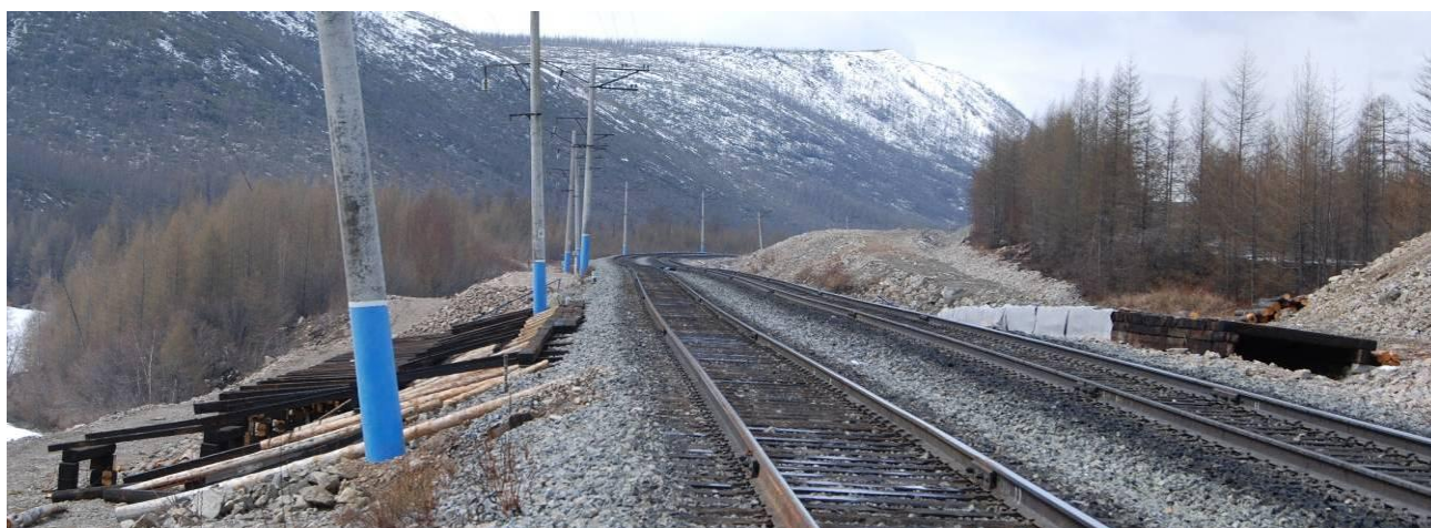
Рис. 6. Солнцесадкозащитные навесы на Восточно-Сибирской ж.д., км 1841 БАМ, май 2011 г
