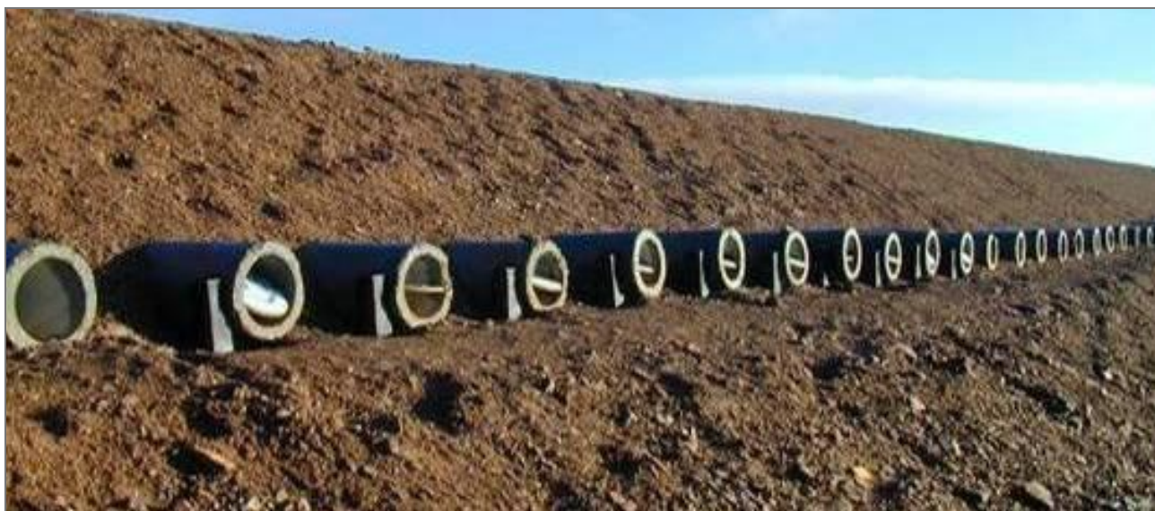
Рис.7. Поперечные вентилируемые железобетонные трубы в земляном полотне Цинхай-Тибетской ж.д. (фото Нью Фуджина)
