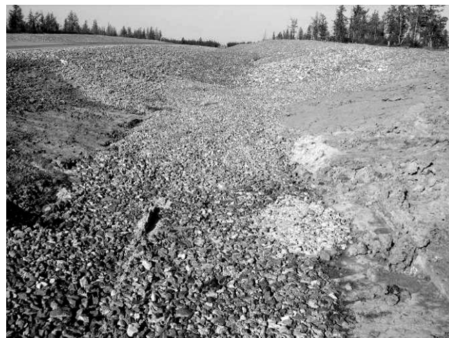
Рис. 2. Противоэрозионная конструкция с заполненной щебнем георешеткой в 2010 г
