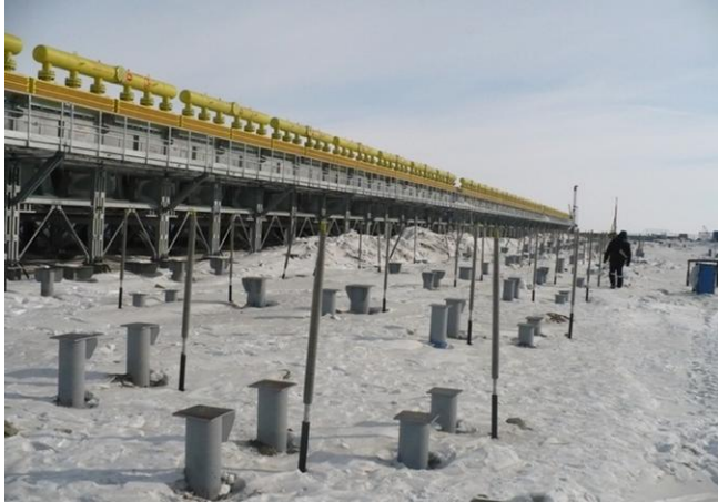
Рис. 2, 3. Монтаж парожидкостных систем термостабилизации многолетнемерзлых грунтов оснований на строящихся промышленных объектах ООО «Газпром добыча Надым» на п-ове Ямал
