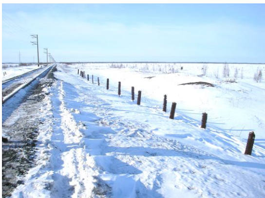
Рис.5. Вид термосифонов при эксплуатации в зимний период
