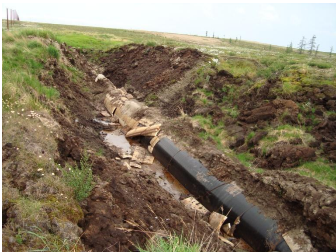
Рис.1. Термоэрозия на участке прокладки подземного газопровода на территории Ямсовейского месторождения, север Западной Сибири. Июль 2009 г. Фото В. Гребенец
